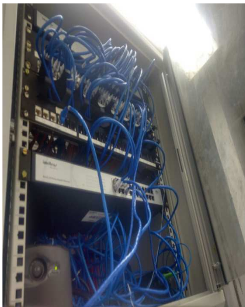
Rack que recebe o sinal da fibra Óptica. Fica no 1º Andar
